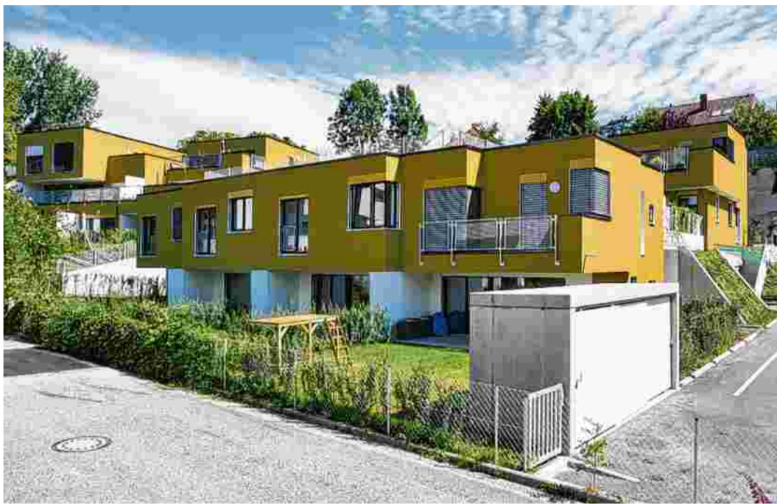
Blick auf die reich gestaffelte und gegliederte Gesamtanlage, die einzelnen Baukörper schaffen Individualität.
